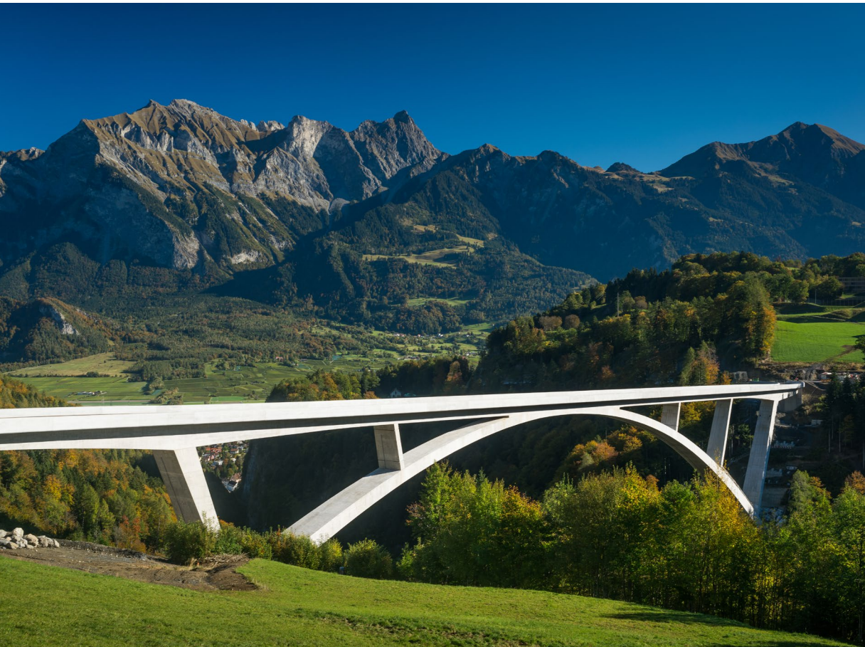
Taminabrücke, Pfäfers Ingenieurbüro Leonhardt, Andrä und Partner, © Foto: Bastian Kratzke
